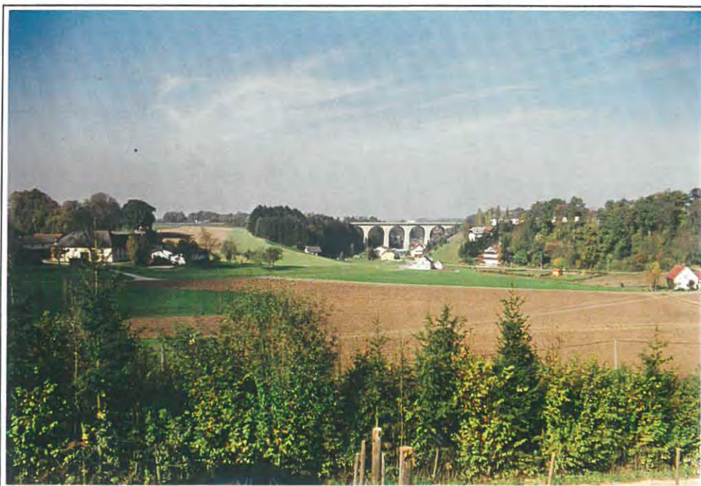
Foto 1: Blick auf die Westautobahnbrücke - nördliches Ende des Projektgebietes
